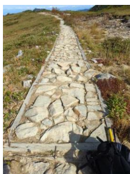
④枠で道を作り石を敷く
